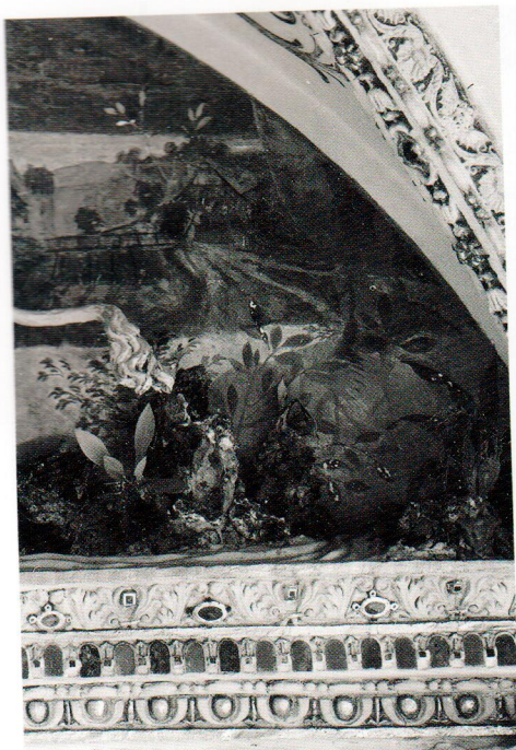
Obr. 20. SZ Bučovice, Císařský sál, jihovýchodní luneta – detail odlupující se malby. Foto: Čestmír Šíla, 1956, Fototéka NPÚ, GnŘ v Praze.
